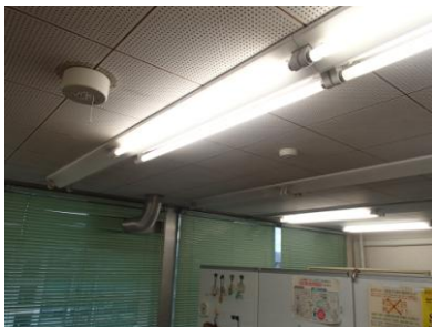
写真1. 不要箇所の照明間引き
