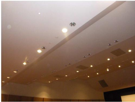
(改修前) 蛍光灯
